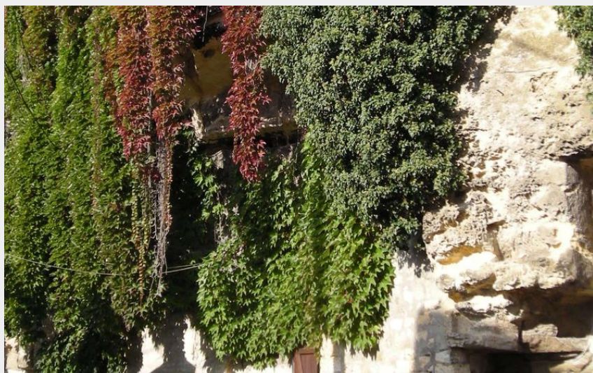
les Carrières, maison troglodytique (admin)
