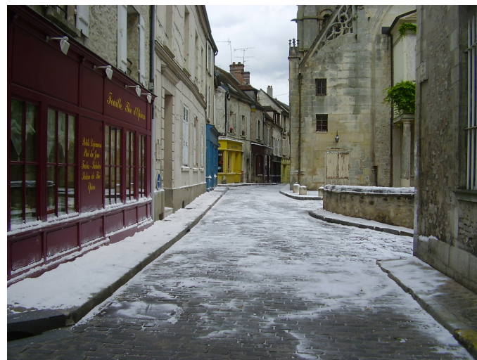
Rue enneigée devant l'ancienne église Saint-Aignan
