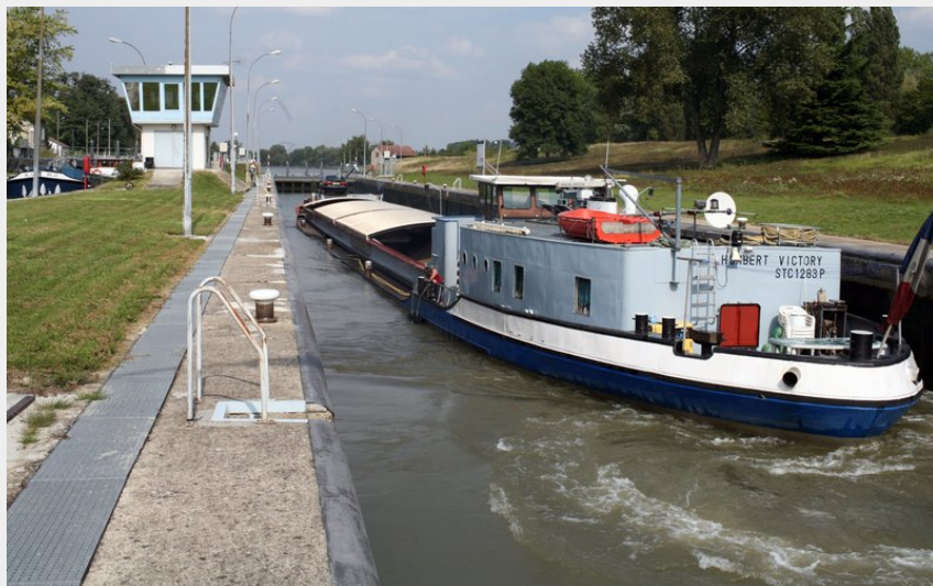
Écluse de Boran-sur-Oise (PNROPF)
